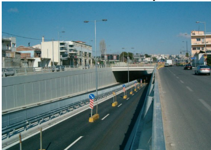
Εικ. 6.16 Τα μεγάλα τεχνικά έργα προκαλούν τις μεγαλύτερες επιπτώσεις στο φυσικό περιβάλλον
