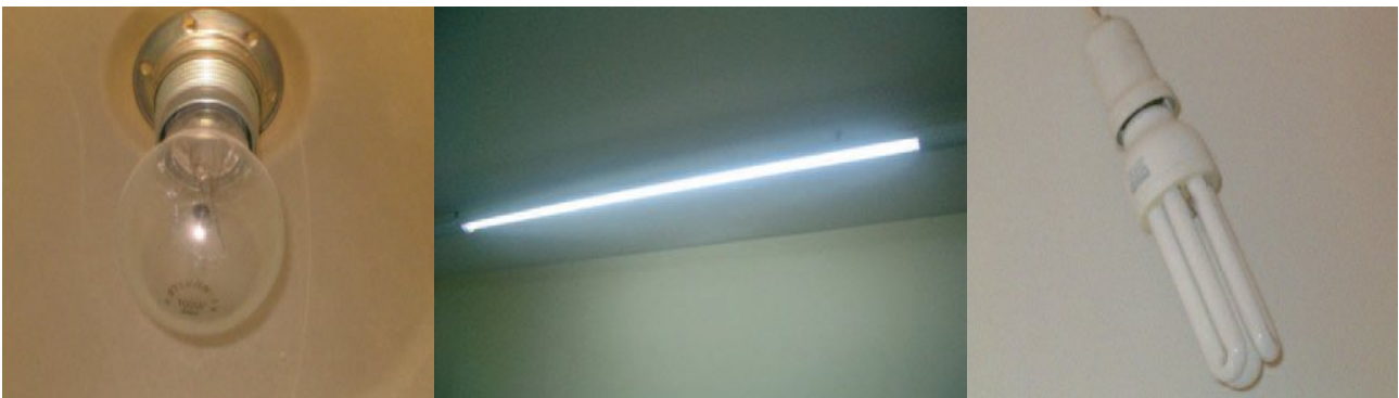
Εικ. 7.3 Διάφορα είδη λαμπτήρων: α) πυράκτωσης, β) φθορισμού, γ) ηλεκτρονικός
