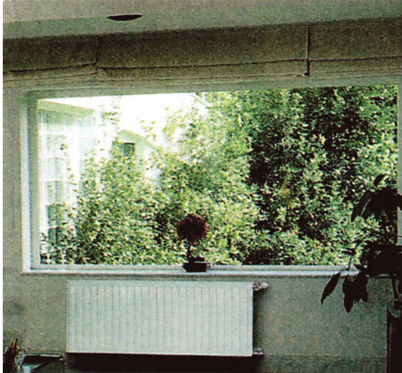
Εικόνα 9.3α Θέση τοποθέτησης των σωμάτων.
