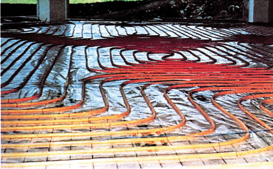
Εικόνα 1.8.3 Σκίτσο ενδοδαπέδιου συστήματος κεντρικής θέρμανσης.
