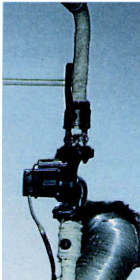
Εικ. (6.2α) Κυκλοφορητής με σφαιρικές βάνες.
