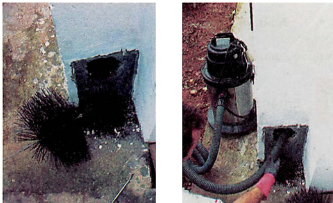
ΣΧ.5.4.β “Σκαντζόχοιρος” στη βάση καμινάδας και καθαρισμός με σκούπα.
