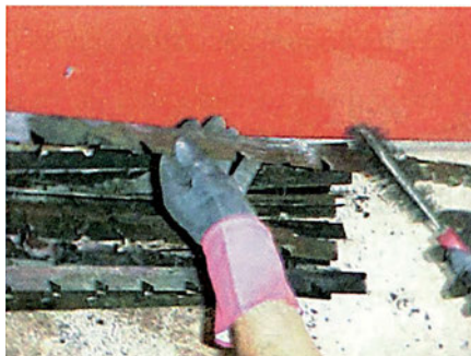
ΣΧ. 4.16.9β Τρίψιμο στροβιλιστήρων με συρματόβουρτσα.
