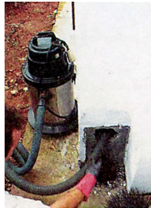
ΣΧ.5.4.α Άνοιγμα οπής καθαρισμού και κάλυψή της με πλακάκι.
