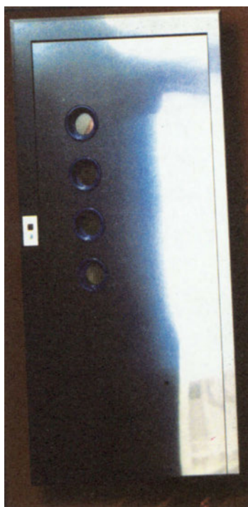
Σχέδιο 3.4 Ανοιγόμενη θύρα ανελκυστήρα
