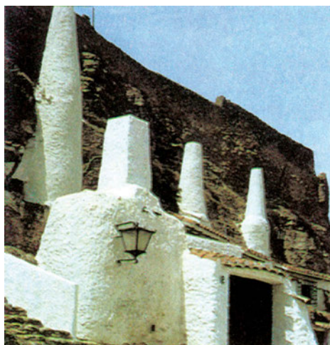
Εικόνα 1.2. Παραδοσιακή καμινάδα φυσικού αερισμού
