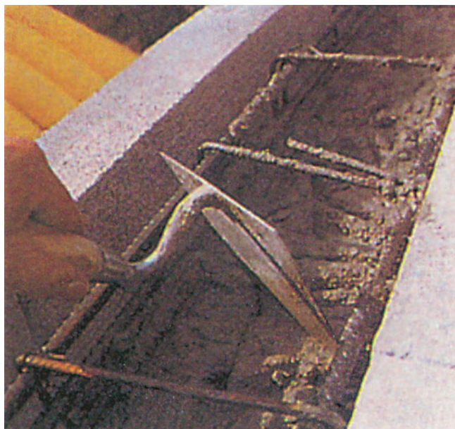
Φωτ 10.29. Περιμετρικό σενάζ από οπλισμένο σκυρόδεμα.
