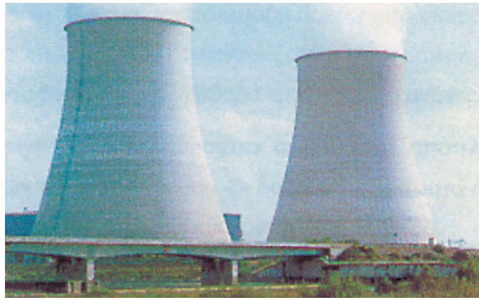
Φωτ. 13.10. Πύργοι ΔΕΗ από οπλισμένο σκυρόδεμα.
