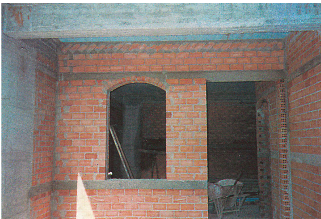
Φωτ. 10.9. Όψη τοίχου με σενάζ και ανοίγματα.
