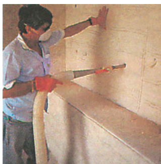
Φωτ. 10.19. Πλήρωση διακένων με μονωτικό υλικό σε κόκκους.
