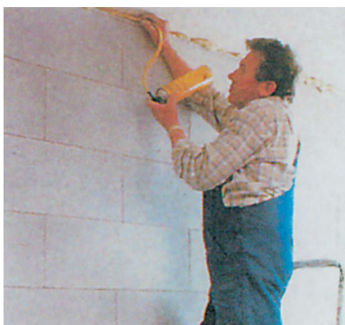
Φωτ. 10.27. Σφήνωμα με διογκωμένη πολυουρεθάνη.
