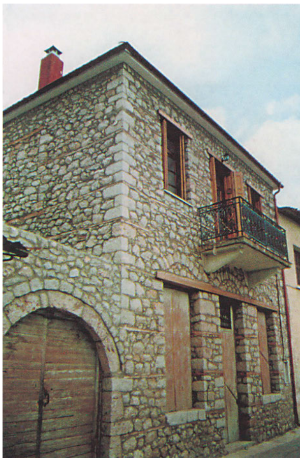
Φωτ. 9.9. Σπίτι στην Αράχωβα. Αργολιθοδομή με υπέρθυρα ξύλινα και λίθινη αψίδα, γωνιόλιθους και ξυλοδεσιές.
