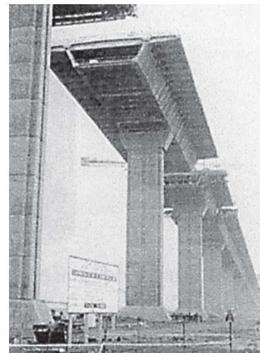
Φωτ. 13.9. Γέφυρα από οπλισμένο σκυρόδεμα στο στάδιο της κατασκευής.
