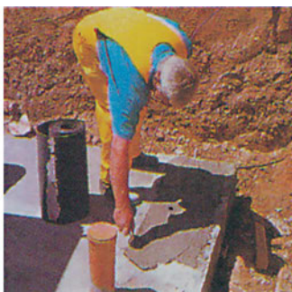
β. Κονίαμα και υγρομόνωση βάσης.
