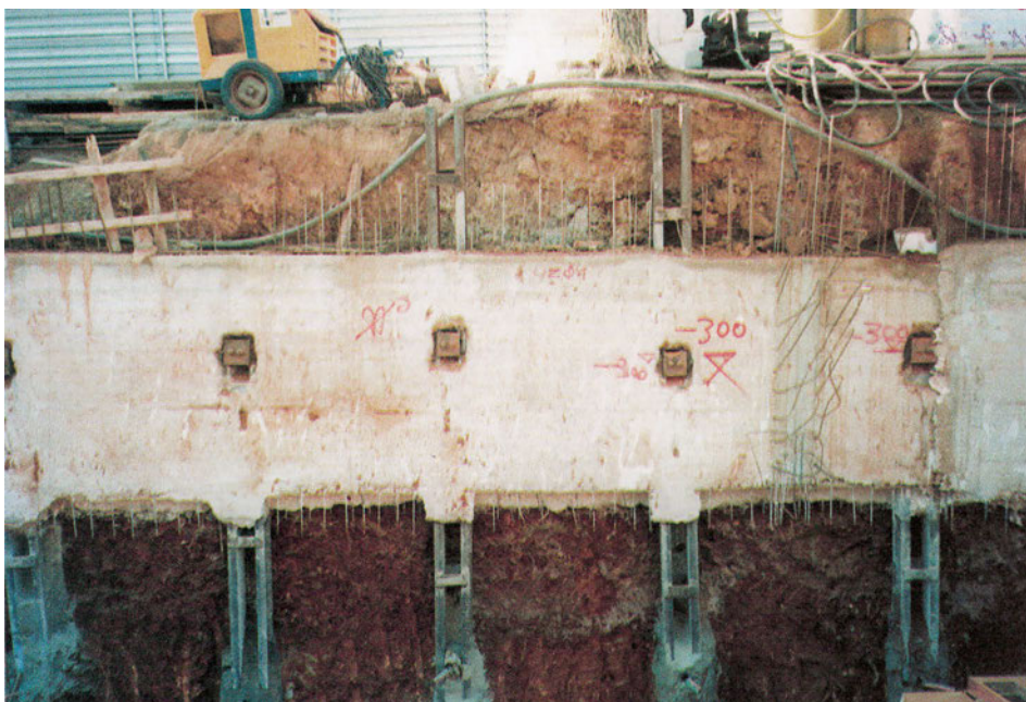
Φωτ. 1. Αντιστήριξη εκσκαφής
