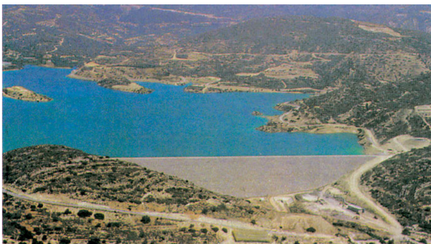
Φωτ. 1.6. Φράγμα Μπραμμανού, Ιεράπετρα, Κρήτη.
