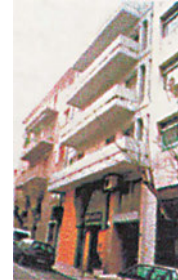
Φωτ. 13.3. Συμβατική πολυκατοικία από οπλισμένο σκυρόδεμα.
