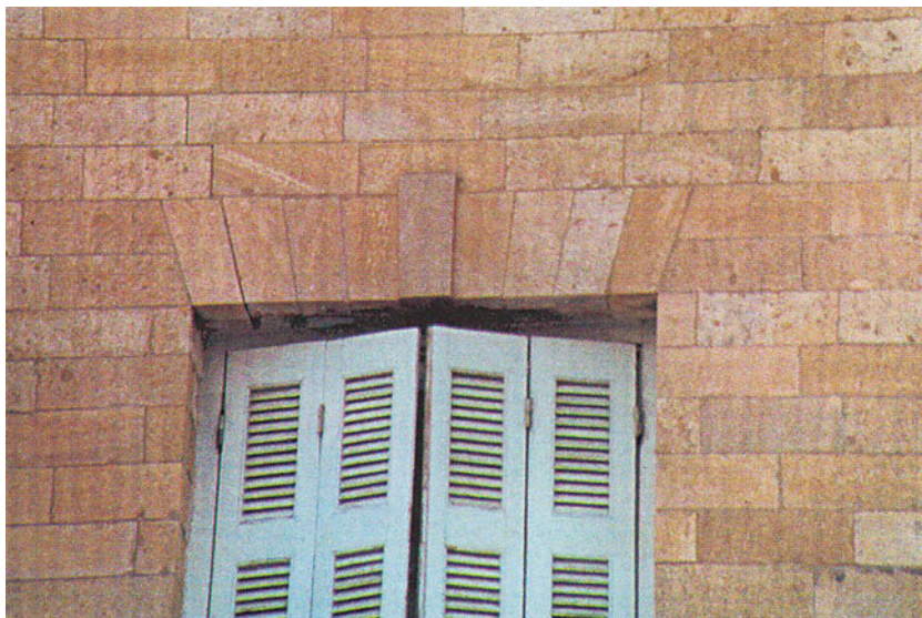
Φωτ. 9.14. Επίπεδο πρέκι από λαξευτές πέτρες. (Ιδιαίτερα επιμελημένη κατασκευή – Σύρος).
