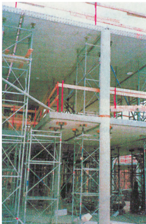
Φωτ. 13.11. Προκατασκευασμένη κατασκευή από οπλισμένο σκυρόδεμα.
