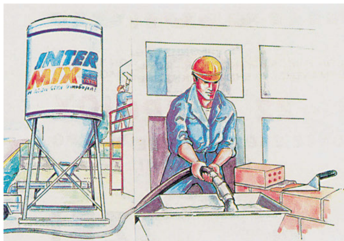
Σχ. 10.4. Δόμηση με έτοιμο κονίαμα.
