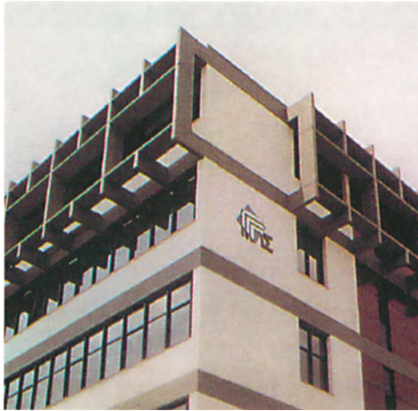
Φωτ. 12.2. Χυτοί τοίχοι και περσίδες από σκυρόδεμα.
