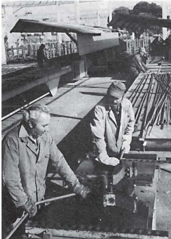
Σχήμα 16.9 Κάμψη οπλισμού με το ειδικό μηχάνημα.
