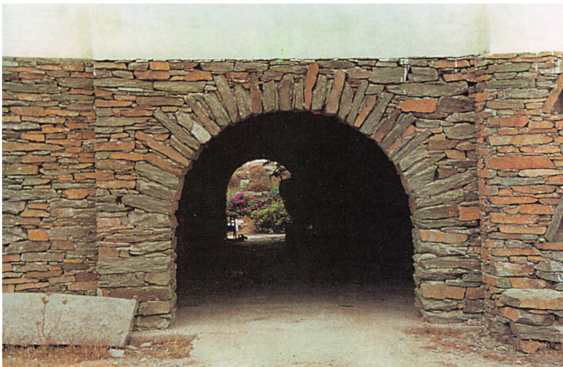
Φωτ. 9.16. Αψίδα σε πλακολιθοδομή στη Τζιζα.
