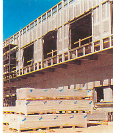
Φωτ. 12.3. Τσιμεντοσανίδες στο κτίριο του Κεντρικού Αεροσταθμού.
