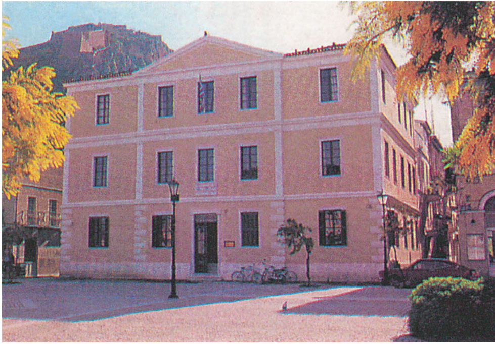
Φωτ. 9.10. Το Δημαρχείο του Ναυπλίου. Επιχρισμένη αργολιθοδομή με λαξευτούς γωνιόλιθους.
