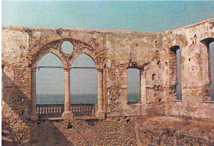
Φωτ. 9.15. Ενετικό κτίσμα στα Χανιά.
