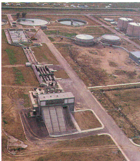
Φωτ. 1.7. Εγκαταστάσεις βιολογικού καθαρισμού Θεσσαλονίκης.
