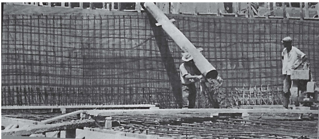
Σχήμα 16.10 Σκυροδέτηση σε εξέλιξη.
