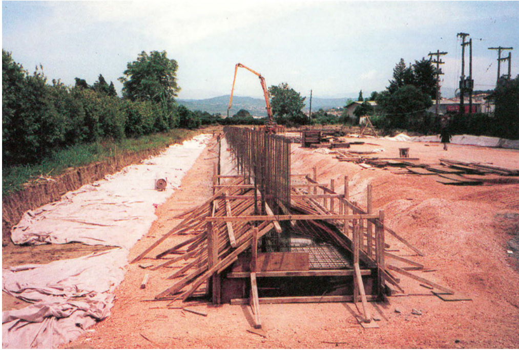
Φωτ. 1. Κατασκευή πεδילוδοκού.
