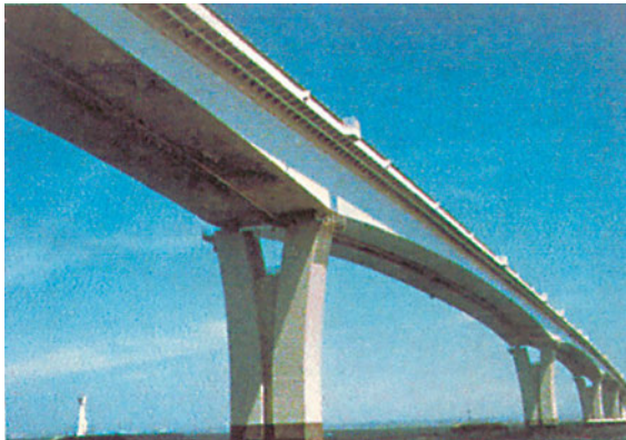
Φωτ. 13.8. Γέφυρα από οπλισμένο σκυρόδεμα.
