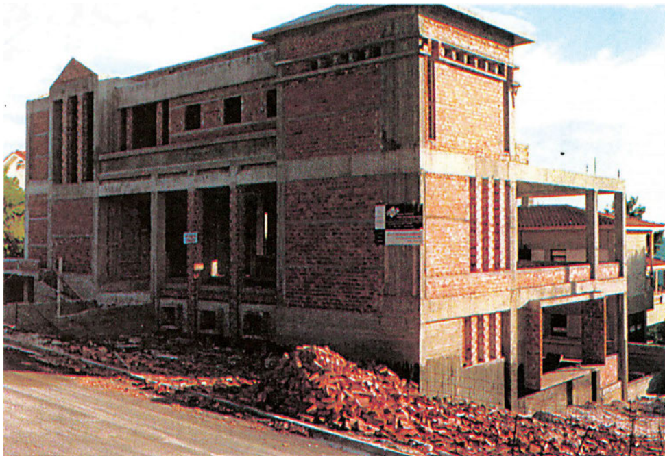
Φωτ. 10.2. Κτίριο με οπτοπλινθοδομή πλήρωσης.
