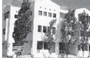
Φωτ. 13.2. Τριώροφη κατασκευή από οπλισμένο σκυρόδεμα.
