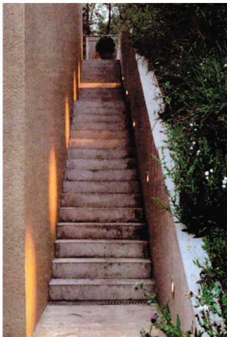
γ.35 Οι φωτεινές περιοχές στον τοίχο μάς βοηθούν να εντοπίσουμε τη σκάλα και διευκολύνουν το ανέθασμα και το κατέθασμα.
