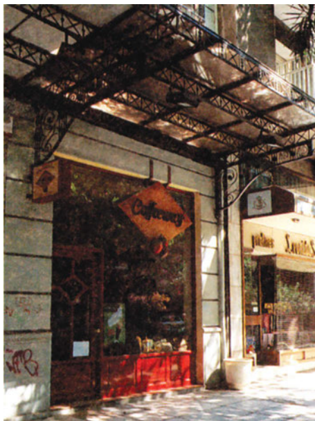
β. 121 Σταθερό στέγαστρο με κλασικής γραμμής μεταλλικά στοιχεία και επικάλυψη από πολυκαρβονικά φύλλα.
