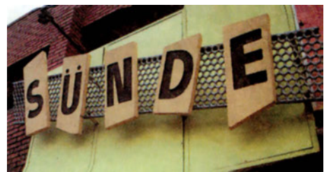
β. 111 Ανεξάρτητα γράμματα, τοποθετημένα σε επίπεδο παράλληλο με αυτό της πρόσοψης.
