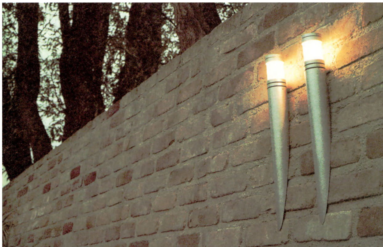
γ.41 Επιτοίχια φωτιστικά με διακοσμητικό φανοστάτη.
