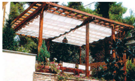
γ.18 Πέργκολα από ξύλο και τεντόπανο. Το μεσαίο δοκάρι χρησιμεύει και για την τοποθέτηση κρεμαστού φωτιστικού. Ο τρόπος τοποθέτησης της τέντας, με εναλλάξ πέρασμα ανάμεσα στις οριζόντιες δοκίδες, δίνει μια ανάγλυφη επιφάνεια.
