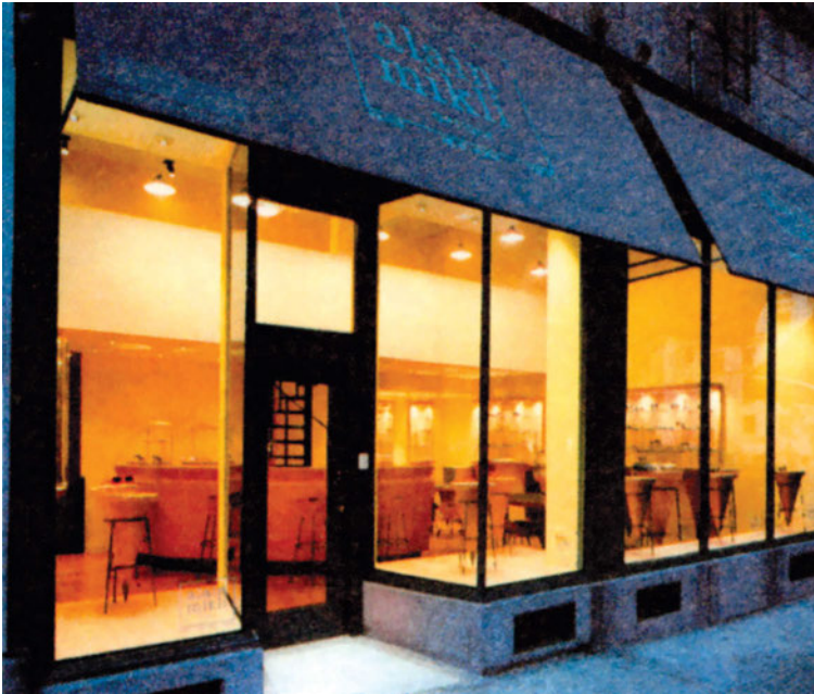
β.119 Κινητό στέγαστρο που προσφέρει επιφάνεια αναγραφής του λογότυπου και δυνατότητα αυξομείωσης του φωτός.
