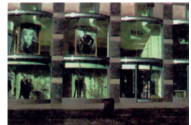
β.8 Το κυλινδρικό σχήμα, με το μέγεθος και την επανάληψή του, καταργεί τον επίπεδο χαρακτήρα της πρόσοψης.
