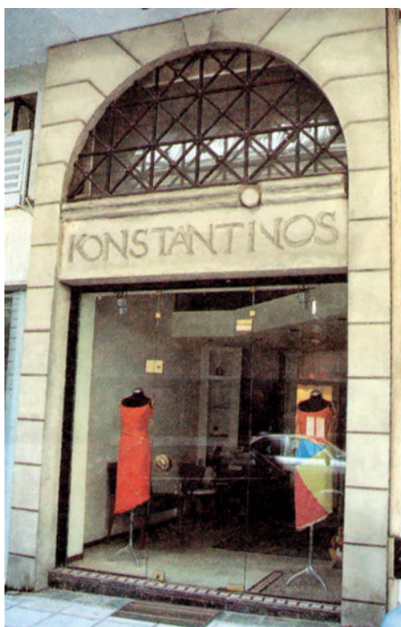
β.114 Οι γραμμικές χαραξίς στο πλαίσιο της πρόσοψης εφαρμόζονται και στην επιγραφή, διαμορφώνοντας έτσι τα γράμματα στο όνομα του καταστήματος.
