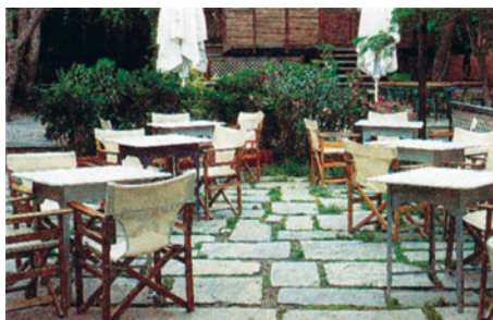
γ.5 Λαξευμένες πέτρες αρμολογημένες με γρασίδι σε εξωτερικό χώρο καταστήματος.
