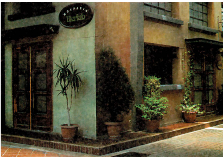
β.126 Κοινός σοβάς καλύπτει τους τοίχους του καταστήματος.
