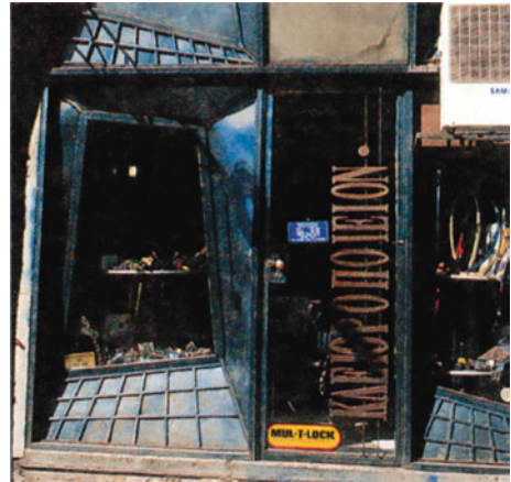
β.12 Πρόσοψη με εσοχές που διαμορφώνουν ασύμμετρα σχήματα και δημιουργούν τη ψευδαίσθηση μεγάλου βάθους.
