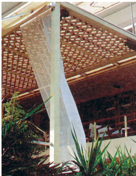
γ. 21 Ελαφρό στέγαστρο από ξύλινο καφασωτό στηριγμένο στον τοίχο του κτιρίου.
