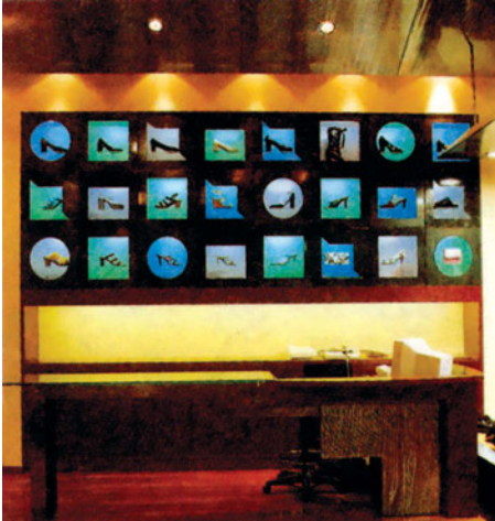
β.38 Μικρά παράθυρα διάφορων σχημάτων, σε κάρναθο, με ένα προϊόν στο καθένα, συνθέτουν το επιτοίχιο εκθετήριο προβολής σε κατάστημα υποδημάτων.
