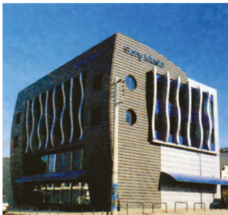
β.1 Ποικιλία μορφών στα στοιχεία των όψεων του κτιρίου, που έχουν διαμορφωθεί ελεύθερα, χωρίς περιορισμούς από το περιβάλλον.
