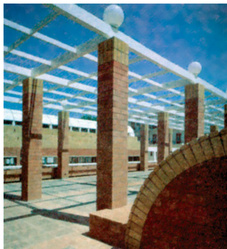
γ.20 Πέργκολα με στηρίγματα από τούβλα και πλέγμα από μπετόν, στοιχεία που δανείζεται από το διπλανό στεγασμένο χώρο.
