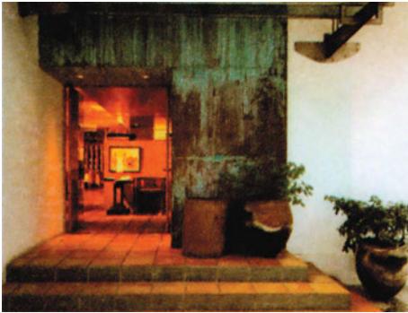
β.131 Φύλλα οξειδωμένου χαλκού καλύπτουν το χώρο εισόδου σε εστιατόριο.
