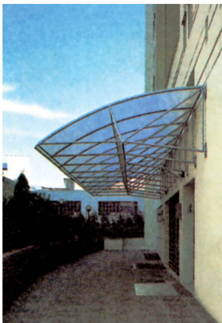
β.118 Στέγαστρα από ελαφρά υλικά, τοποθετημένα στην πρόσοψη εκ των υστέρων. Προστατεύουν μεγάλο τμήμα της πρόσοψης και κυρίως την είσοδο.
