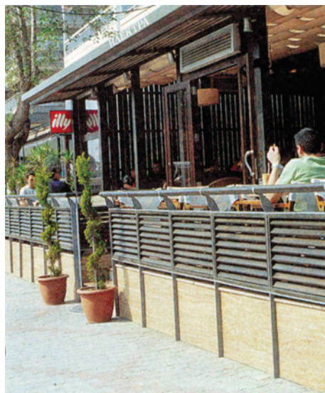
γ.27 Ξύλινο κιγκλίδωμα από απλά γραμμικά στοιχεία πάνω σε σταθερό τοίχο οριοθετεί τον εξωτερικό χώρο του καταστήματος.
