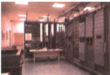
Εικ. 14. Εσωτερικός χώρος κατανεμητή
