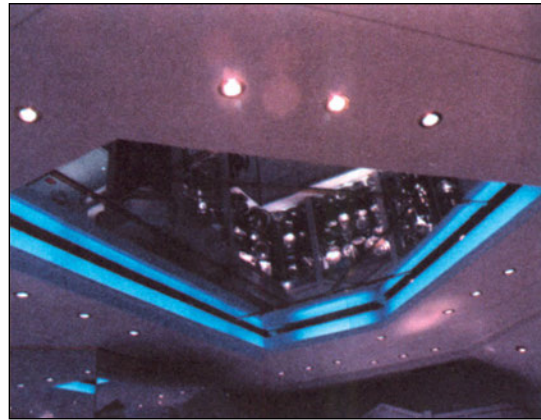
Εικ. 20. Ο σωστός φωτισμός είναι πολύ σημαντικός παράγοντας, διότι επηρεάζει τις πωλήσεις. Μπορεί να είναι συνδυασμός λαμπτήρων φθορισμού, προβολείς δέσμης αλογόνου (12 volts), με αυξομείωση της έντασης ή και λαμπτήρες πυράκτωσης.
