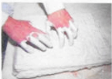
Τοποθέτηση της τζιβας με γύψο πάνω στο πρώτο λεπτό στρώμα.
