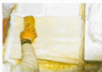
Τοποθέτηση και επικόλληση του 2ου πανιού.
