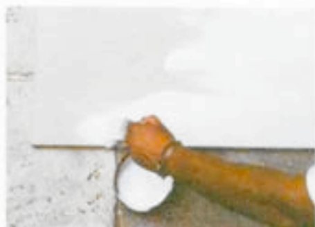
Πέρασμα του πρώτου στρώματος της προετοιμασίας
