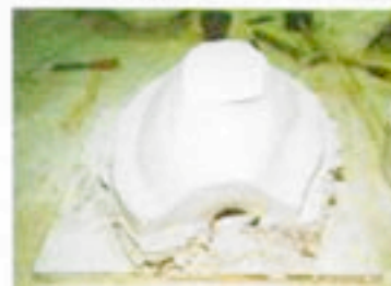
Κατασκευή εσάρπας στην πρώτη πλευρά.
