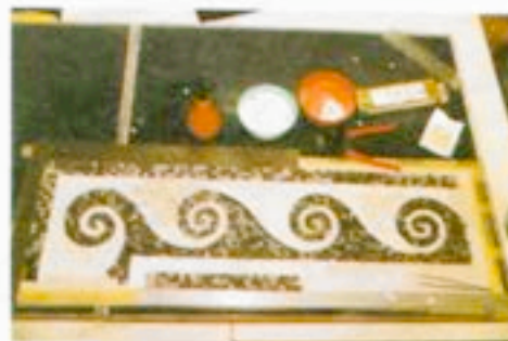
Διαδικασία κατασκευής τμήματος ψηφιδωτού δαπέδου.
