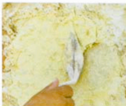
Πέρασμα με το μυστρί του ασβεστοκονιάματος
