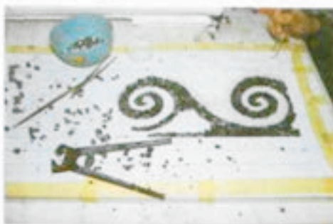
Διαδικασία κατασκευής τμήματος ψηφιδωτού δαπέδου.
