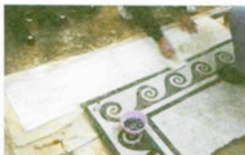
Διαδικασία τοποθέτησης ψηφιδωτού στο δάπεδο.
