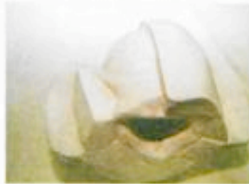
Κατασκευή σπαστού καλουπιού της πίσω πλευράς.
