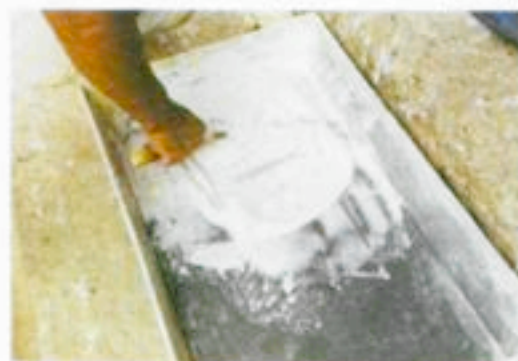
Προετοιμασία ασβεστοκονιάματος
