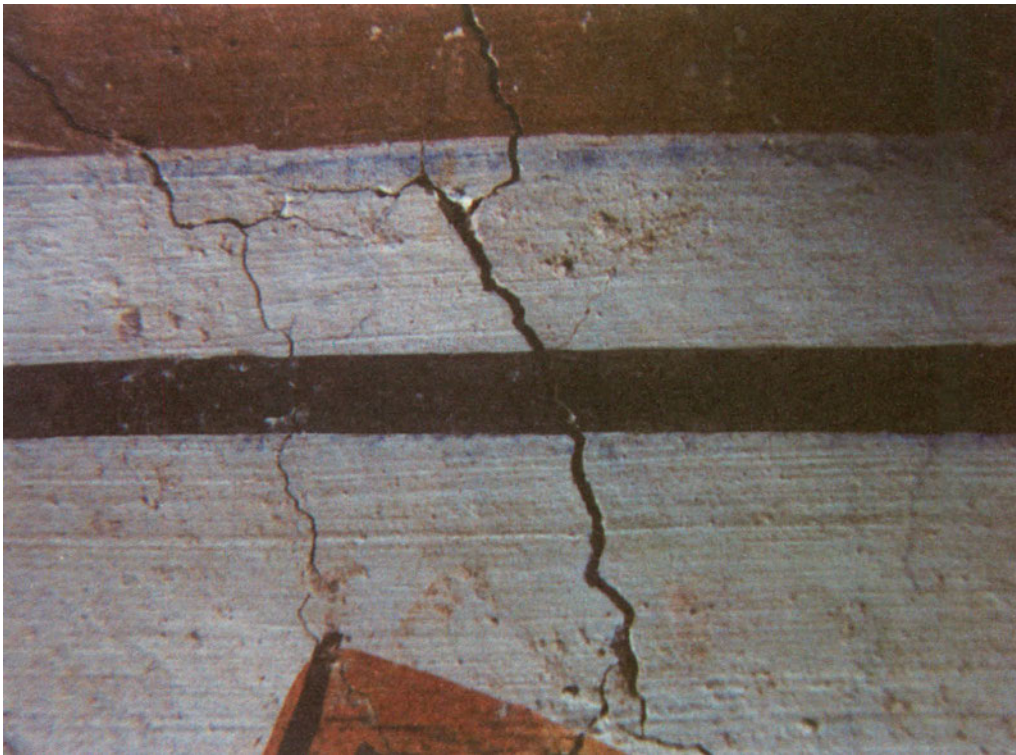
Λεπτομέρεια ρωγμής σε τοιχογραφία
