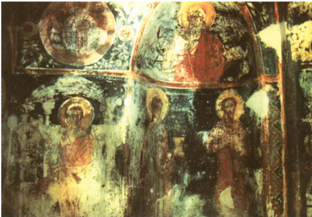
Φθορές τοιχογραφίας λόγω της επίδρασης της υγρασίας
