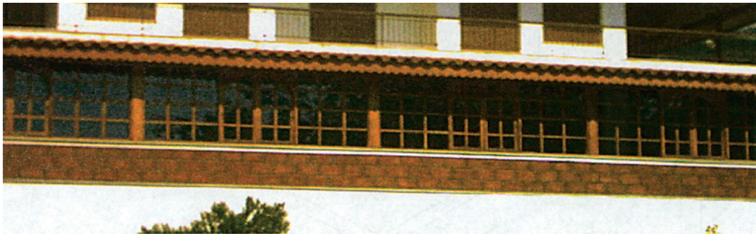
Εικ. 4.52. Κατασκευή ναλοστασίου με καΐτια.
