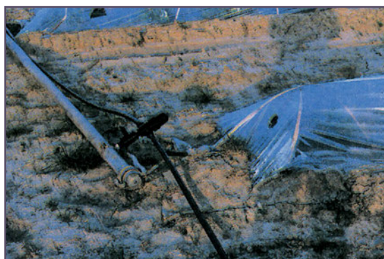
Σχήμα 14.1.1γ Σωλήνας PE διανομής και σωλήνας μεταλλικός μεταφοράς νερού
