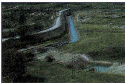
Σχήμα 14.4.2α Φρεάτιο ηρεμίας
