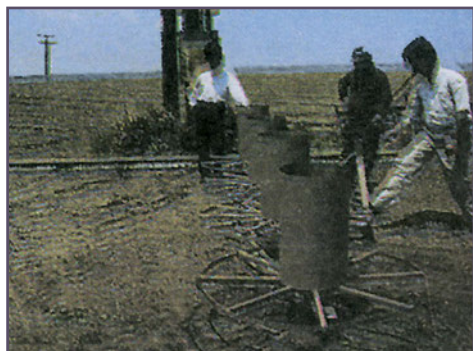
Σχήμα 14.6.2γ Εγκατάσταση σταλακτοφόρου
