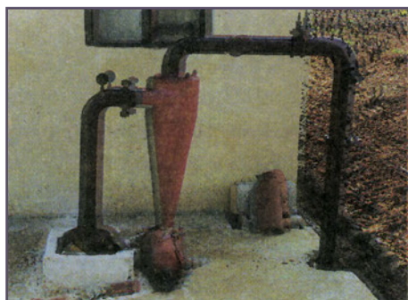
Σχήμα 14.4.3α Φίλτρο υδροκυκλώνα
