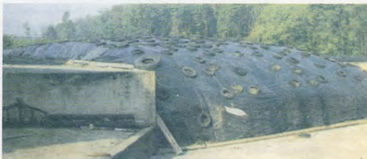
Εικόνα 2.12: Αεροστεγές κλείσιμο σιρού με πλαστικό υλικό
