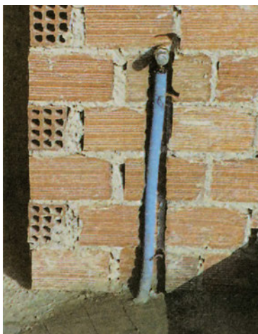
ΦΩΤ. 2.16.γ Σωλήνας τροφοδότησης εξωτερικής βρύσης. Η τοποθέτηση αυτών των σωλήνων γίνεται πριν από το σοβάτισμα για να μη τον σκάβουμε, στην αντίθετη περίπτωση. Αν ο σωλήνας είναι πλαστικός και αντικαθιστάμενος, τότε πριν από το σοβάτισμα τοποθετούμε μόνον το εξωτερικό του σπιράλ.
