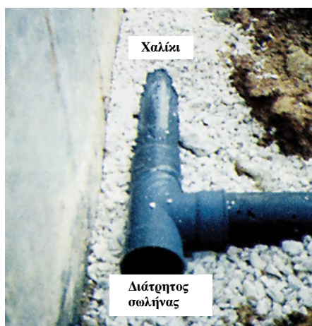
ΣΧ.4.11.β Τοποθέτηση σωλήνα αποστράγγισης υπογείων υδάτων.
