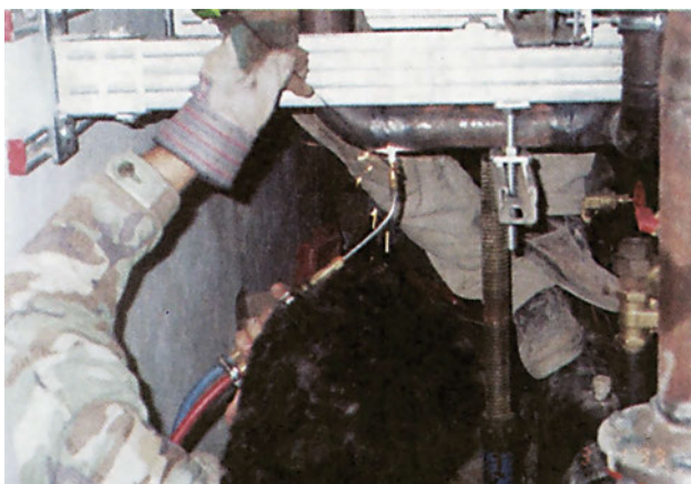
ΣΧ.8.2.2.γ Με συγκολλήσεις οξυγόνου - ασετιλίνης κατασκευάζουμε πλήθος υδραυλικών δικτύων.
