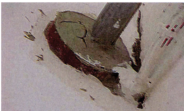
ΦΩΤ. 3.5.α Γέμισμα διέλευσης σωλήνων με ειδικά άκαυστα υλικά, ώστε να μη μεταδίδεται η φωτιά από δωμάτιο σε δωμάτιο.
