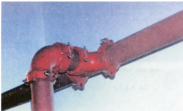
ΣΧ.8.2.2.ι Λυόμενη σύνδεση σε δίκτυο πυρόσβεσης.
