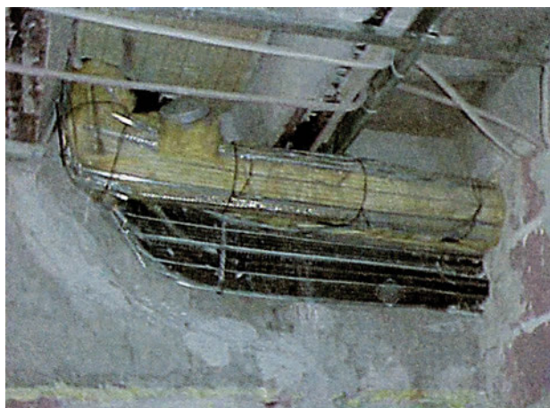
ΦΩΤ. 3.5.γ Ηχομόνωση σωλήνων αποχέτευσης στην οροφή σαλονιού. Το μολυβδόφυλλο τυλίγεται με πάπλωμα από πετροβάμβακα, πάχους τουλάχιστον 2 εκατοστών. Ακολουθεί η τοποθέτηση μεταλλικού πλέγματος που θα συγκρατήσει καλύτερα το σοβά. Η τελική κάλυψη γίνεται με γυψοσανίδα.
