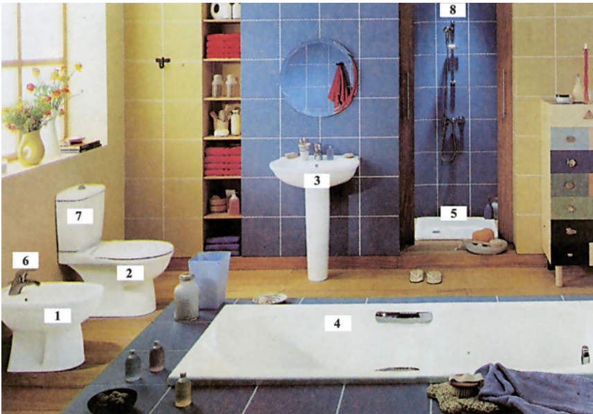
ΣΧ. 7.2.α Μπάνιο οικοδομής. Διακρίνονται ο μπιντές (1), η λεκάνη (2), ο νιπτήρας (3), η μπανιέρα (4), η ντουζιέρα (5), η μπαταρία ανάμειξης ζεστού και κρύου νερού (6), το καζανάκι χαμηλής πίεσης (7) και ο μηχανισμός διασποράς νερού (8).
