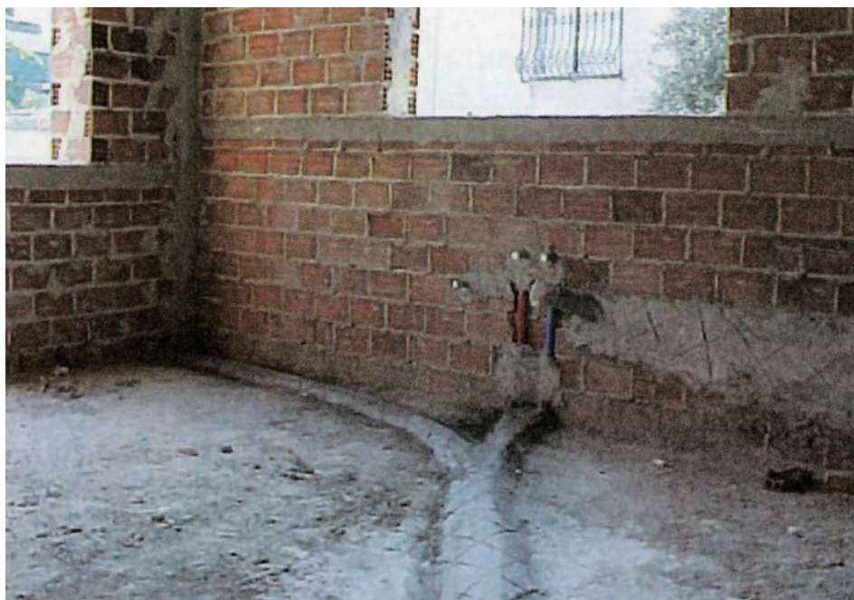
ΦΩΤ. 2.5.α Σωστή προστασία σωλήνων ύδρευσης. Η οικοδομή είναι καθαρή από μπάζα, όταν εκτελούνται υδραυλικές εργασίες. Η τσιμεντόλασπη καλύπτει πλήρως και αποτελεσματικά τους σωλήνες από ενδεχόμενα χτυπήματα άλλων συνεργείων.
