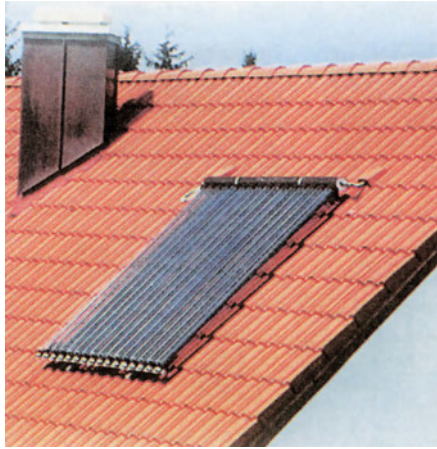
ΦΩΤ. 2.17.2.δ Ηλιακοί συλλέκτες τοποθετημένοι με ιδιαίτερη προσοχή σε κεραμοσκεπή οικοδομής, ώστε να μη ξεχωρίζουν πολύ από τα κεραμίδια.
