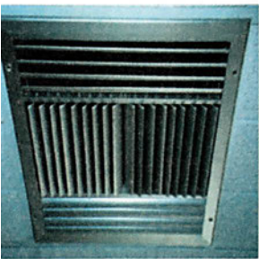
Ορθογωνικό στόμιο οροφής, με ρυθμιζόμενα πτερύγια
