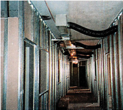
Εικόνα 5.6: Κεντρικός αεραγωγός εξαερισμού κατά μήκος (στο άνω αριστερό μέρος) ενός διαδρόμου σε χώρο γραφείων. Ο αεραγωγός συνδέεται με εύκαμπτους αεραγωγούς (δεξιά) που καταλήγουν σε στόμια εξαερισμού μέσα στα γραφεία.
