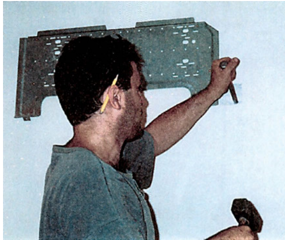
Εικόνα 3.12: Τοποθέτηση της μεταλλικής βάσης για το «κρέμασμα» της εσωτερικής μονάδας στον τοίχο και άνοιγμα της τρύπας για τη σύνδεσή της με την εξωτερική μονάδα.
