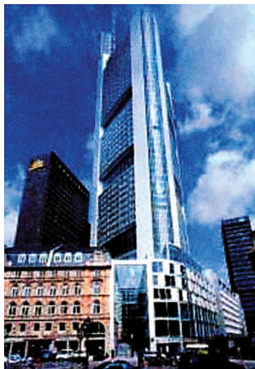
Εικόνα 1.14: Γενική όψη του κτιρίου.
