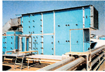
Εικόνα 1.9: Κεντρικές κλιματιστικές μονάδες (ΚΚΜ). Διο μικρού μεγέθους ΚΚΜ (αριστερά) με είσοδο και παροχή 100% εξωτερικού αέρα και μεγάλο μεγέθους ΚΚΜ (δεξιά) με μείξη εξωτερικού αέρα και αέρα επιστροφής.
