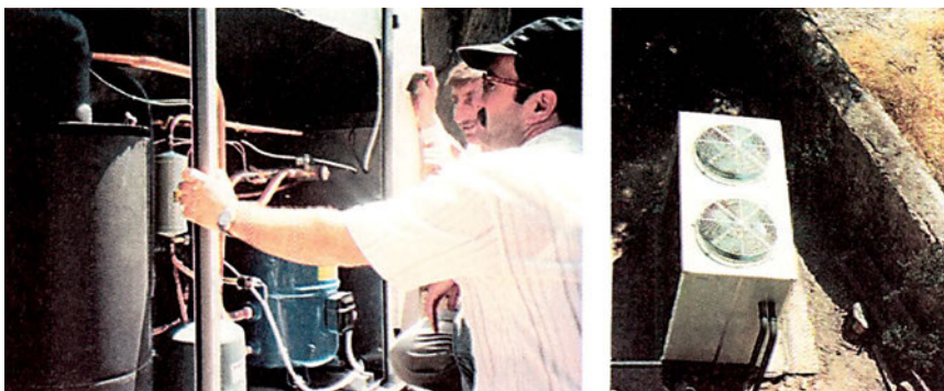
Εικόνα 3.3: Εξωτερική κεντρική μονάδα αντλίας θερμότητας αέρα-νερού μεσαίου μεγέθους (30 kW). Αριστερά, τα εξαρτήματα της αντλίας θερμότητας, αφού έχει αφαιρεθεί το προστατευτικό κάλυμμα της μονάδας. Δεξιά, οι δυο αξονικοί ανεμιστήρες της μονάδας. Σημ.: Για τη διανομή του ζεστού/κρύου νερού στις τοπικές κλιματιστικές μονάδες, χρησιμοποιείται μία αντλία.
