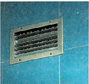
Ορθογωνικό στόμιο τοίχου, με ρυθμιζόμενα πτερύγια.
