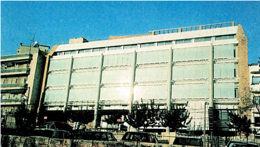
Εικόνα 1.17: Γενική όψη του κτιρίου.
