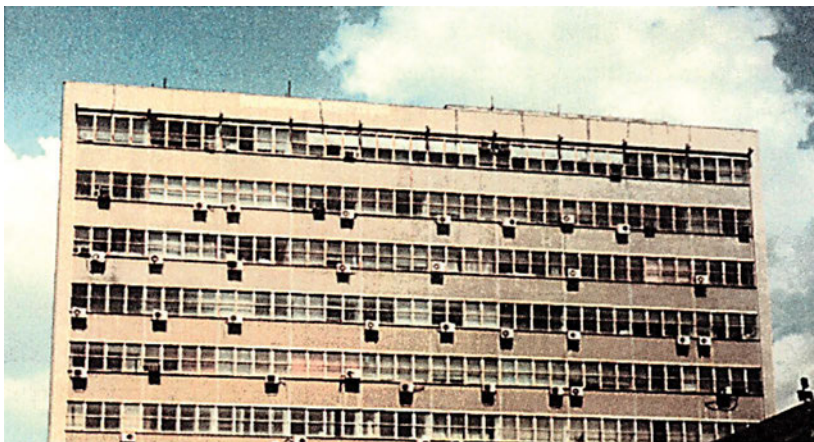
Εικόνα 3.1: Μικρές αυτόνομες κλιματιστικές μονάδες διαιρούμενου τύπου και μερικές ενιαίες μονάδες παραθύρου για τον κλιματισμό ανεξάρτητων χώρων σε κτίριο γραφείων.
