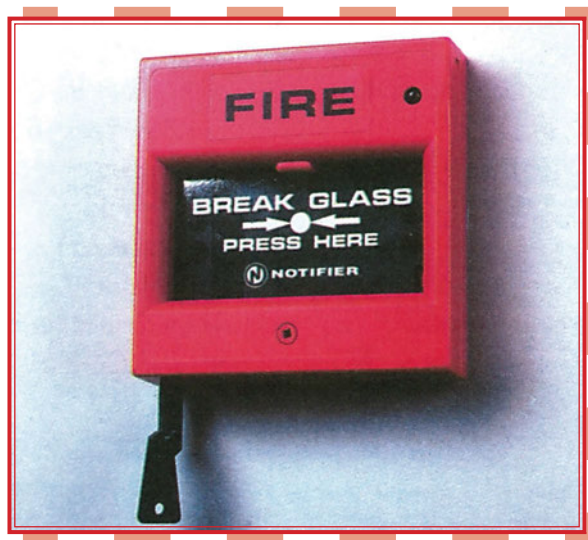
Εικόνα 1.1: Συσκευή χειροκίνητης κλήσης
