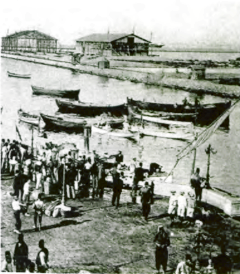
Λιμάνι: Έργα επέκτασης
