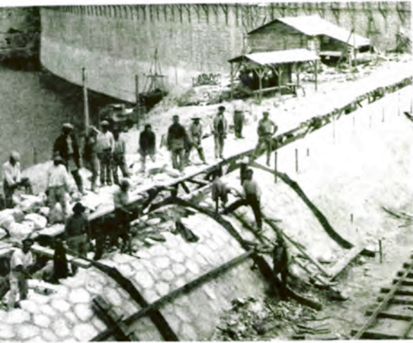
Εργοτάξιο στο φράγμα του Μαραθώνα, 1928
