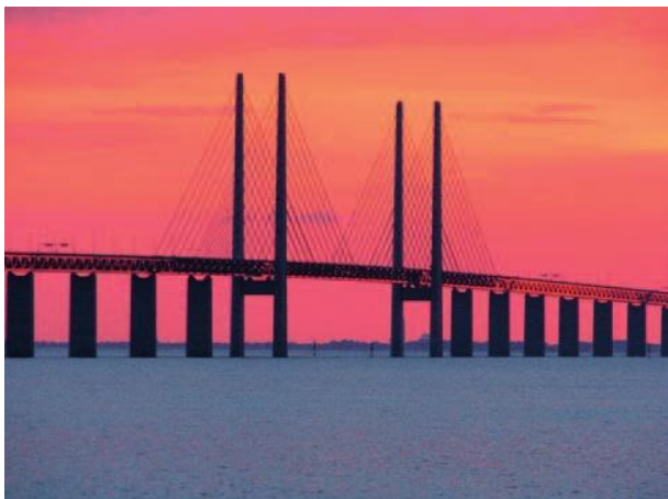
43.4 Η Γέφυρα του Όρεσουντ ενώνει τη Δανία με τη Σουηδία
