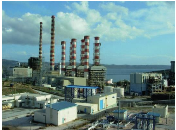
42.7 Λαύριο: θερμοηλεκτρικός σταθμός Δ.Ε.Η.
