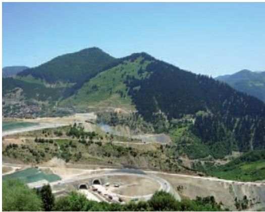
Σήραγγα στην Εγνατία Οδό
