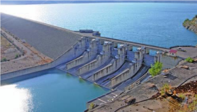
Το φράγμα και η τεχνητή λίμνη Στράτου
