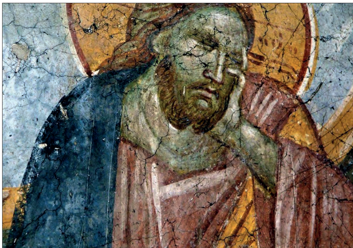
Οι λεπτές ρωγμές στην επιφάνεια των τοιχογραφιών είναι αποτέλεσμα συστολών και διαστολών του σοβά.
