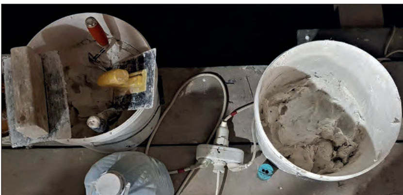
Τα υλικά για την «όψη» του φρέσκο, ασβέστης με λινάρι, μυστριά και τριβίδια.
