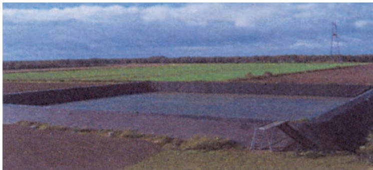
Εικ. 6.7 Ανοιχτή χωμάτινη ημιυπόγεια δεξαμενή αναερόβιας χώνευσης αποβλήτων χοιροστασίου
