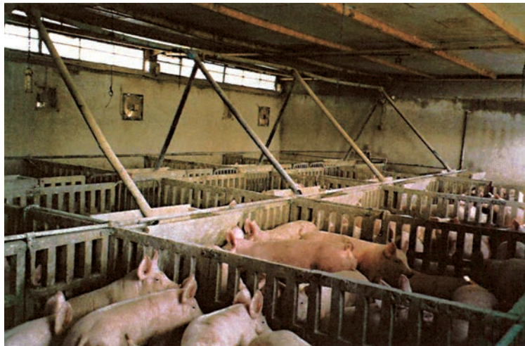
Εικ. 5.7 Τυπικό παχυντήριο χοίρων στη χώρα μας με πλήρες σχαρωτό δάπεδο και τιμεντένια χωρίσματα κελιών και ταΐστρα.
