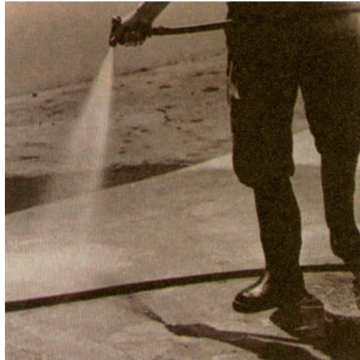
Εικ. 15.20 Πλύσιμο του προαυλίου χώρου με νερό υπό πίεση
