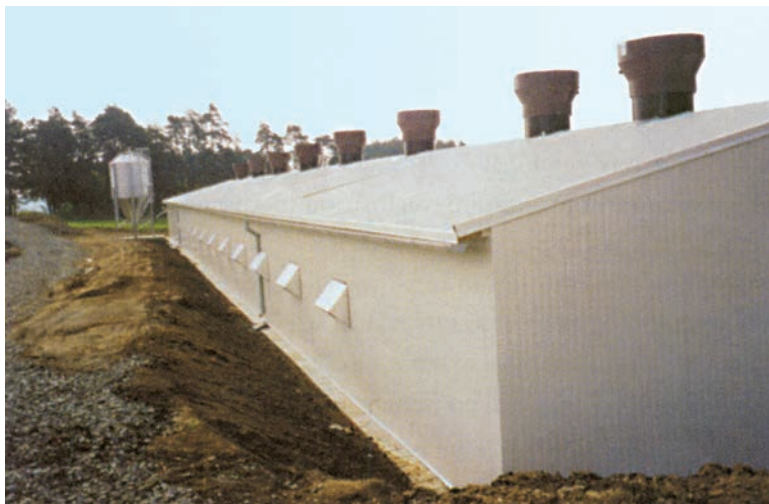
Εικ. 4.17 Χοιροστάσιο κλειστού τύπου κατασκευασμένο εξ ολοκλήρου από panels
