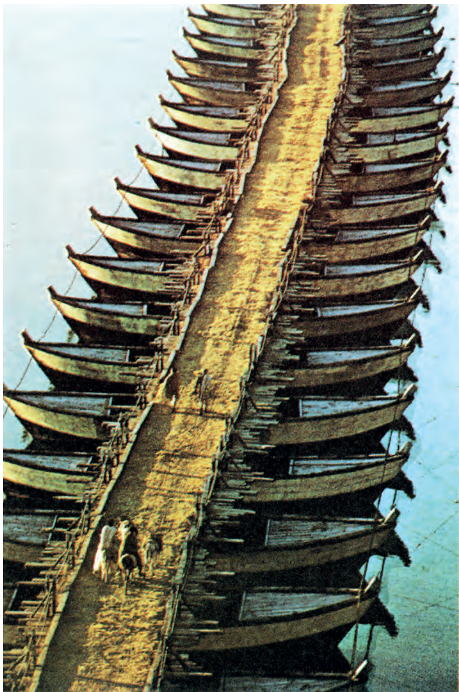
Λεμβόζεγκτη γέφυρα του Κωφίνα.
