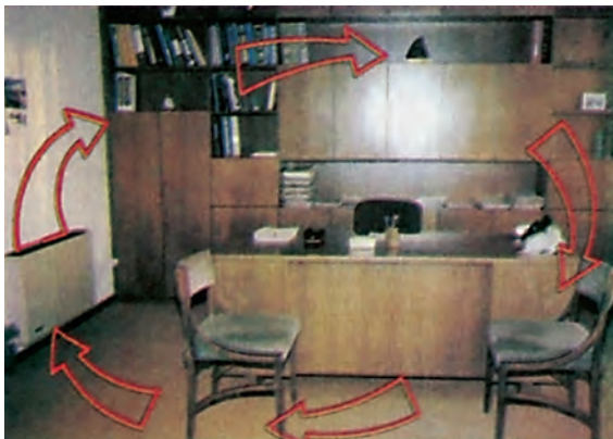
Εικ. 9.1.β α) convector φυσικής κυκλοφορίας
