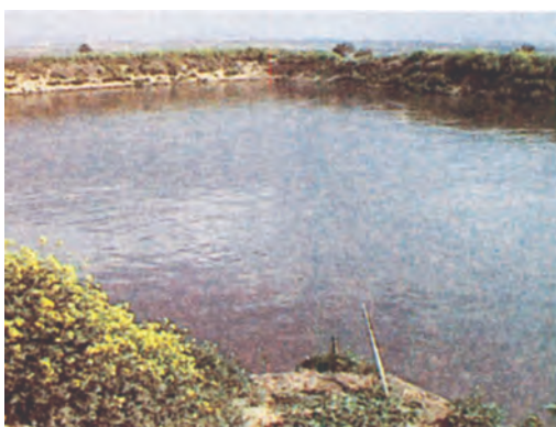
Εικόνα 3-30. Αποθήκευση υγρών αποβλήτων σε ανοικτή αναερόβια δεξαμενή.
