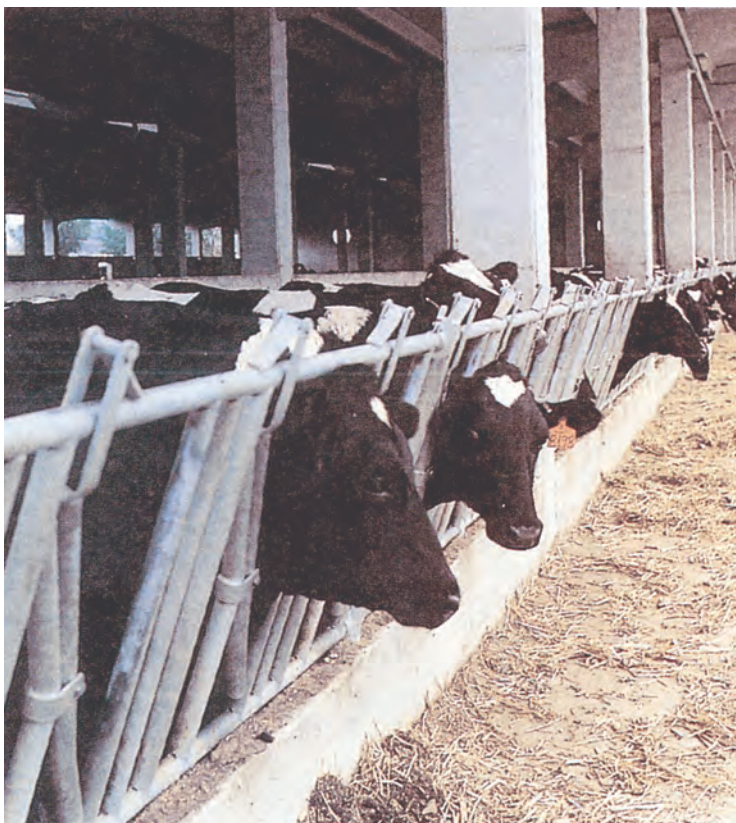
Εικόνα 1-27. Βουστάσιο με αγελάδες γαλακτοπαραγωγής. Χορήγηση τροφής στο δάπεδο (διάδρομος τροφοδοσίας)
