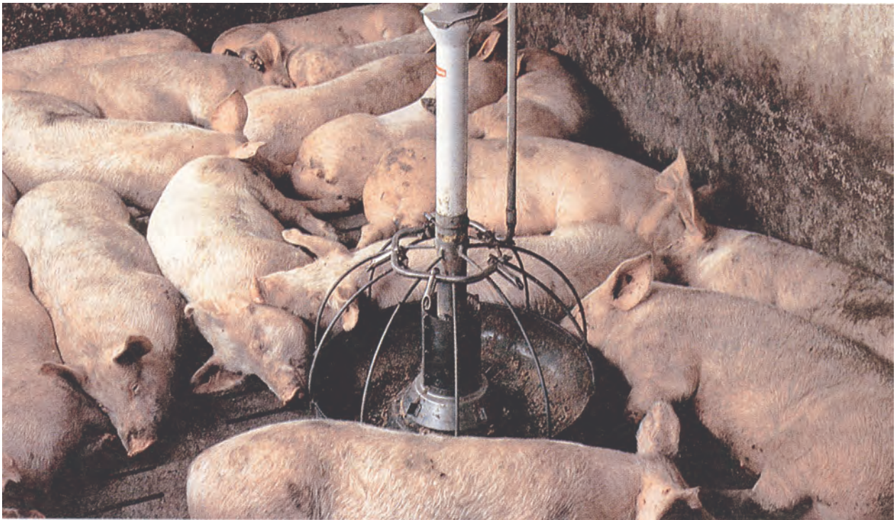
Εικόνα 3-14. Σύστημα αυτόματης τροφοδοσίας χοίρων
