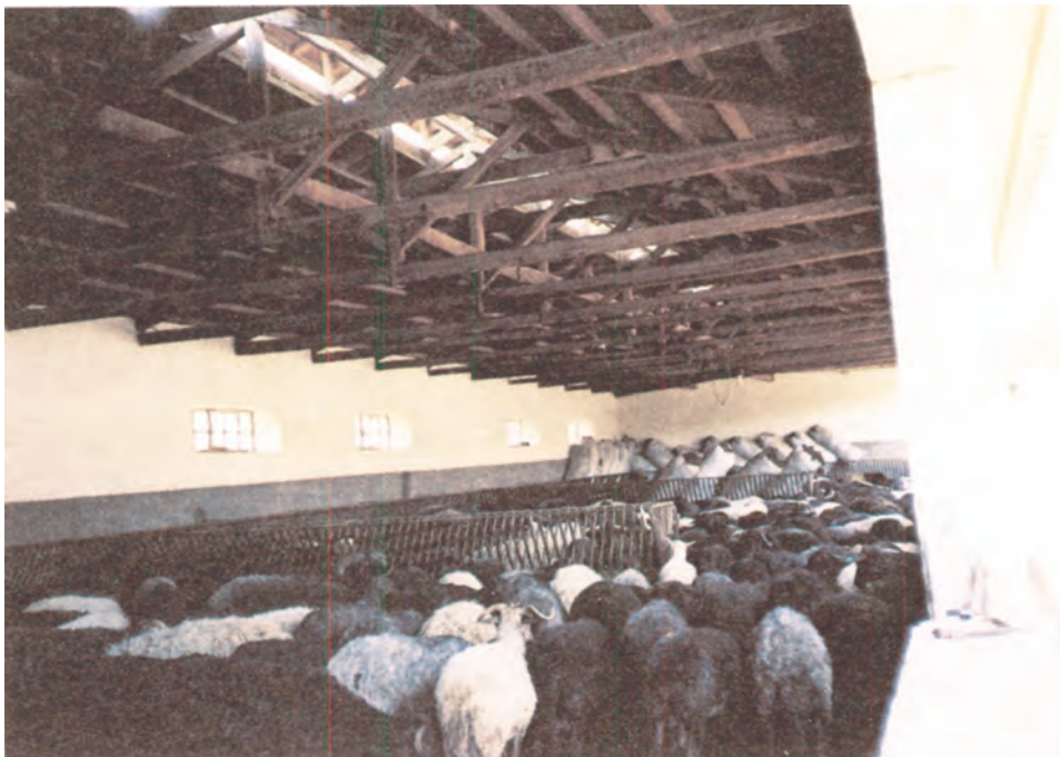
Εικόνα 2-31. Σύγχρονο προβατοστάσιο κλειστού τύπου με σύστημα αερισμού στην οροφή
