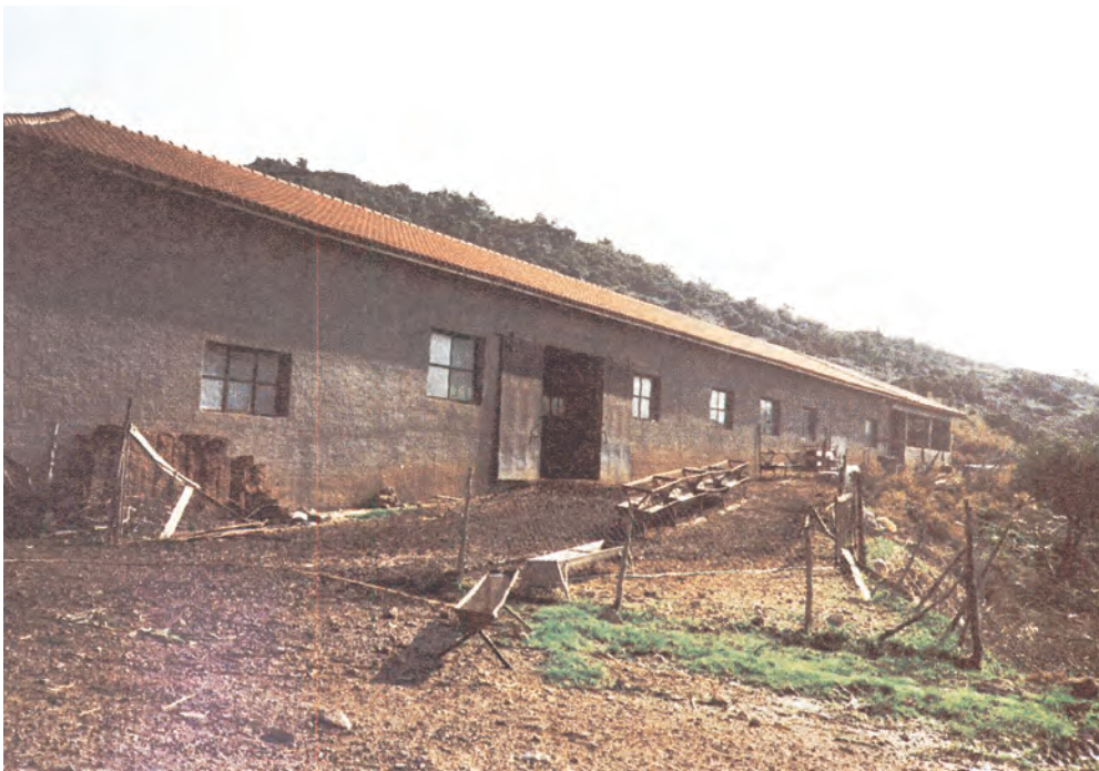
Εικόνα 2-28. Σύγχρονο προβατοστάσιο κλειστού τύπου
