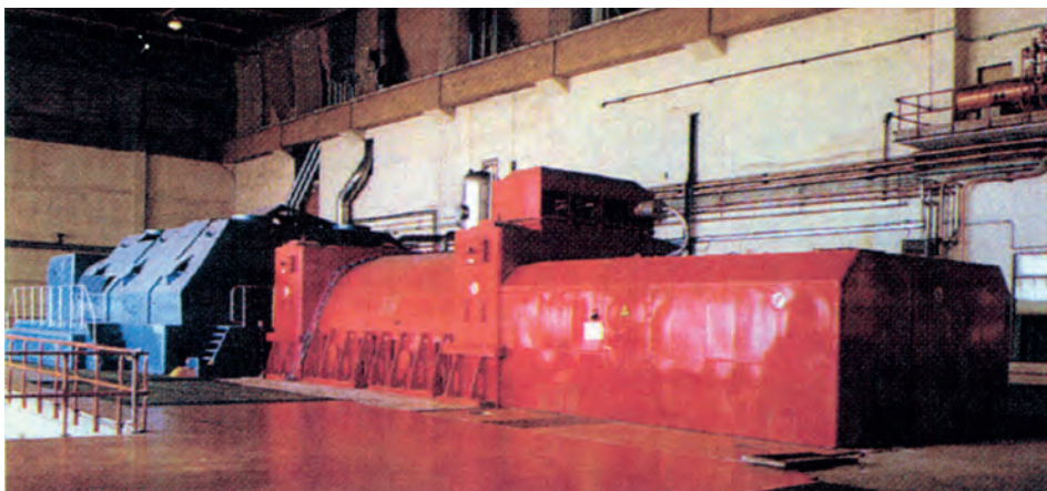
Σχ. 3.13: Συγκρότημα ατμοστροβιλοεναλλακτήρα.
