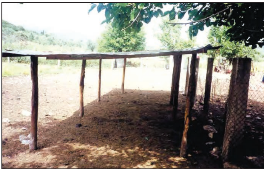
Εικόνα 13.53: Στέγαστρο σε προαύλιο προβατοστασίου για δημιουργία σκιάς
