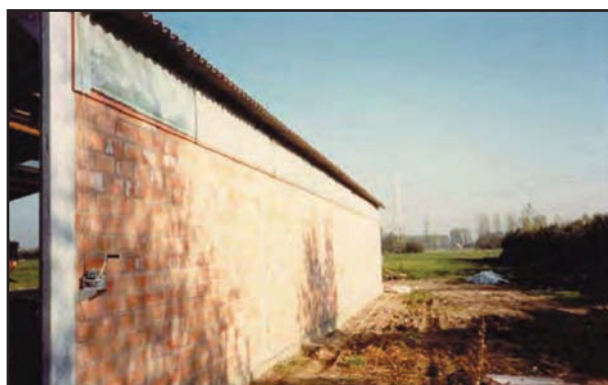
Εικόνα 13.48: Κουρτίνα και ανεμοφράκτης για περιορισμό της ταχύτητας του αέρα και λεπτομέρεια κατασκευής του
