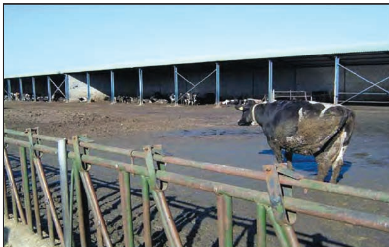
Εικόνα 6.65: Προαύλιο βουστασίου με κακή στράγγιση στο οποίο καταλήγουν και τα νερά από τη στέγη του στάβλου
