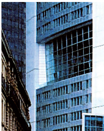
Εικόνα 1.16: Μερική όψη του κτιρίου.
