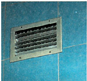
Ορθογωνικό στόμιο τοίχου, με ρυθμιζόμενα πτερύγια.
