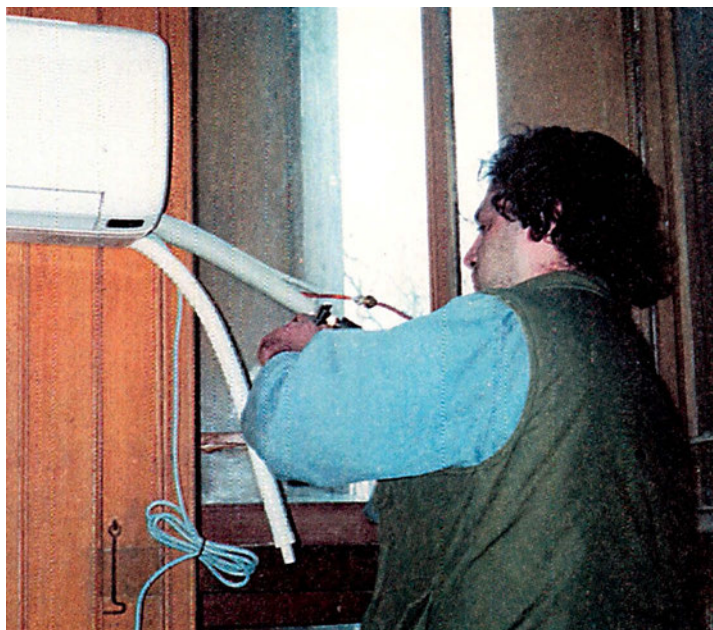
Εικόνα 3.14: Προετοιμασία συνδέσεων εσωτερικής μονάδας που θα «περάσουν» στην εξωτερική πλευρά. (Διακρίνονται: το καλώδιο παροχής ρεύματος στην εξωτερική μονάδα, οι αναμονές της εσωτερικής μονάδας με τον σωλήνα των συμπυκνωμάτων και οι αντίστοιχες των δυο χαλκοσωλήνων για το ψυκτικό ρευστό).
