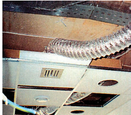
Εικόνα 5.6: Κεντρικός αεραγωγός εξαερισμού κατά μήκος (στο άνω αριστερό μέρος) ενός διαδρόμου σε χώρο γραφείων. Ο αεραγωγός συνδέεται με εύκαμπτους αεραγωγούς (δεξιά) που καταλήγουν σε στόμια εξαερισμού μέσα στα γραφεία.
