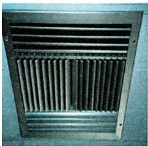
Ορθογωνικό στόμιο οροφής, με ρυθμιζόμενα πτερύγια
