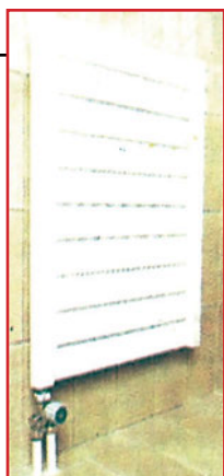
Εικόνα 2.6: Επίπεδα θερμαντικά σώματα
