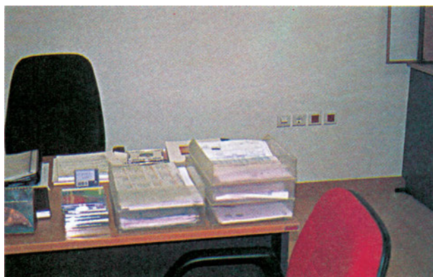
Χώρος εργασίας με εγκατάσταση δομημένης καλωδίωσης
