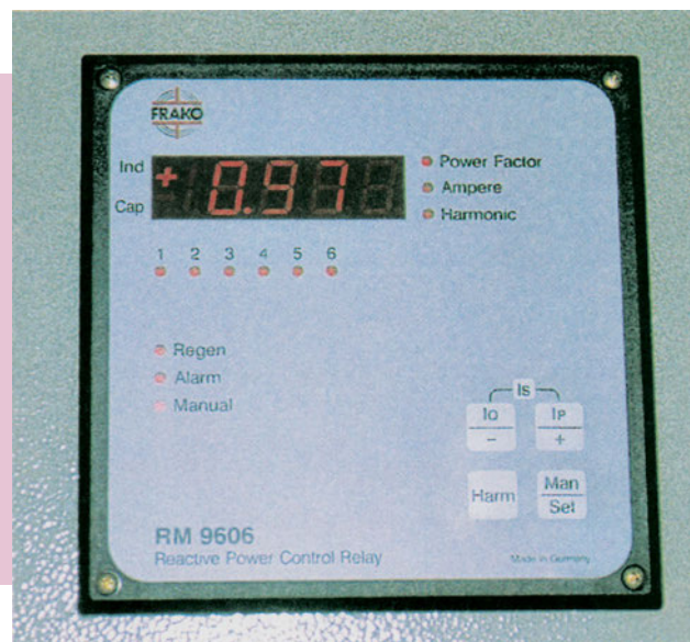
Συσκευή αυτόματης ρύθμισης \cos\varphi
