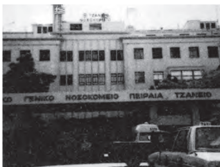
ΕΙΚΟΝΑ 6.1. Περιφερειακό Γενικό Νοσοκομείο Πειραιά «ΤΖΑΝΕΙΟ».
