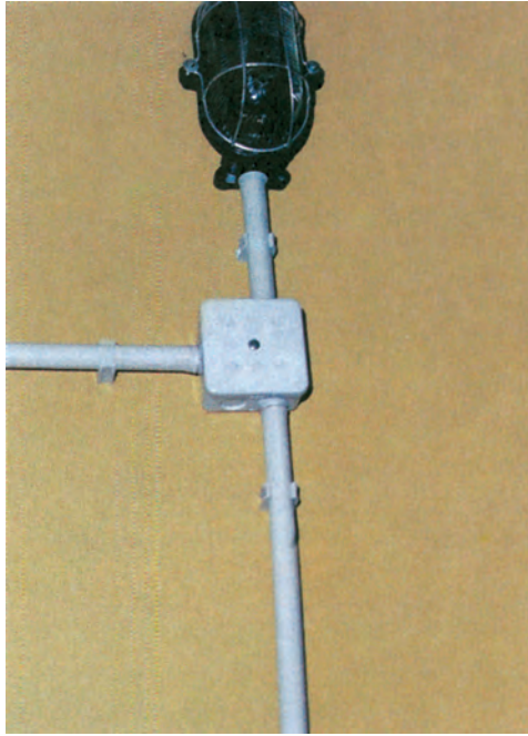
Φωτογραφία 6.4.3.α Ορατή εγκατάσταση με ευθύγραμμους πλαστικούς σωλήνες βαρέος τύπου
