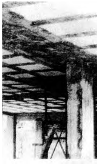
Εικ. 208 Μόνωση πλακών με διογκωμένη πολυστερίνη.
