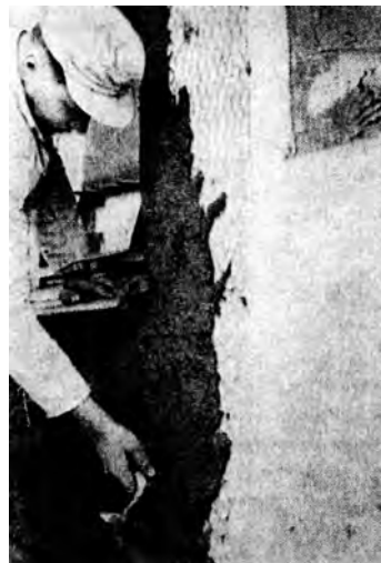
Εικ. 211 Εφαρμογή θερμομονωτικού σοβά.
