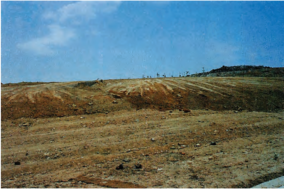
Φωτ. 9-22: Διάστρωση εδαφών στον αποκαθιστούμενο χώρο διάθεσης απορριμμάτων στα Άνω Λιόσια. (Πηγή: Αρχείο Αικ. Σκοτίδα)
