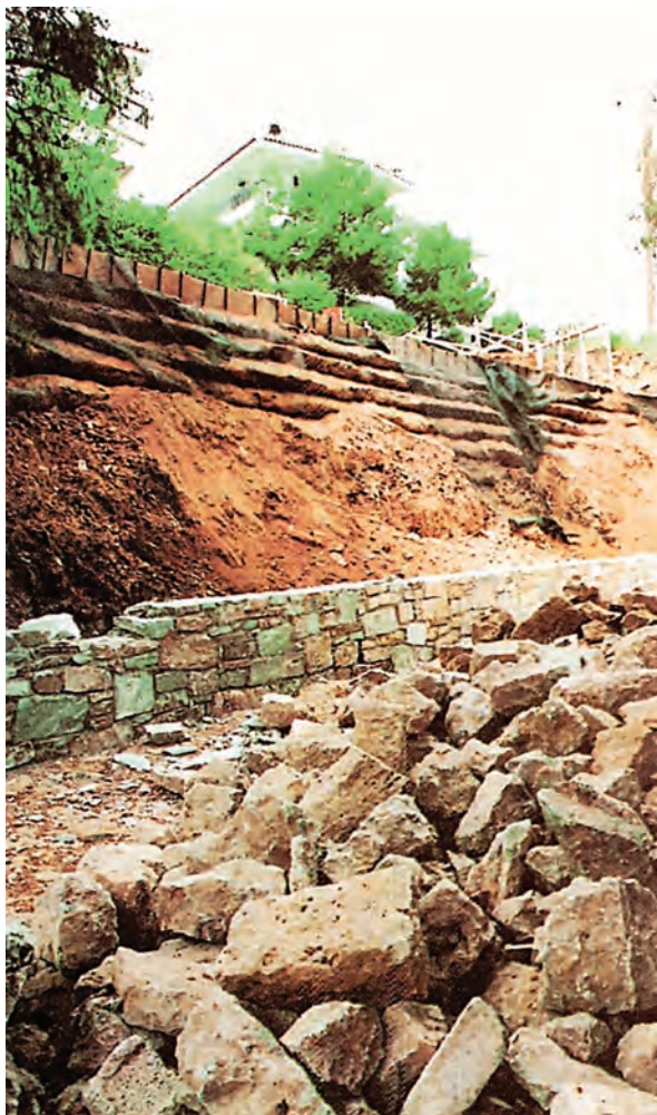
Φωτ. 7-6: Αποκατάσταση ρέματος Χαλανδρίου.
