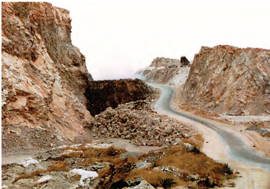
Φωτ. 9-12: Άποψη χώρου διάθεσης απορριμμάτων σε λατομική περιοχή
