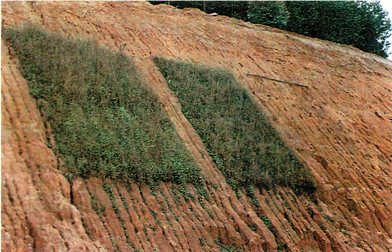
Φωτ. 9-20: Υπόδειγμα δοκιμαστικού πρασινισμού πρανών μεγάλων κλίσεων με διαφορετικά σπορομίγματα αγροστωδών και λειμώνιων φυτών. (Πηγή: Αρχείο Σ. Σεκλιζιώτη)
