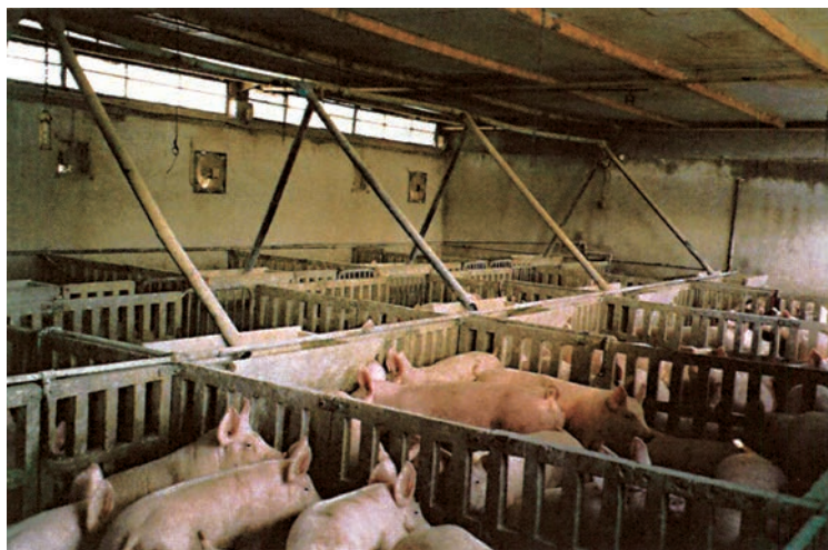
Εικ. 5.7 Τυπικό παχυντήριο χοίρων στη χώρα μας με πλήρες σχαρωτό δάπεδο και τσιμεντένια χωρίσματα κελιών και ταϊστρα.
